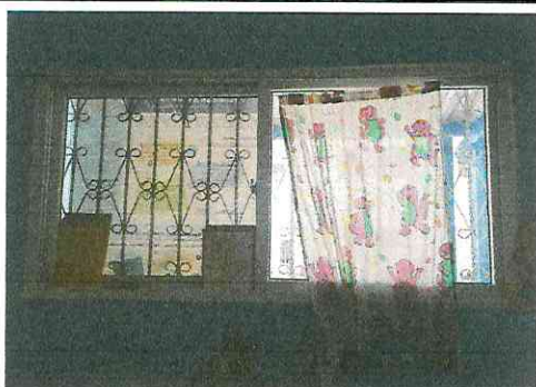
Foto 5: Instalacion de ventanas pvc mas vidrio
