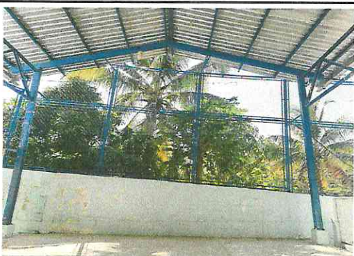
Foto 3: Ampliacion de altura de muro perimetral com marco de maya galvanizada
