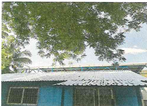
Foto 1: sustitucion de lamina por lamina troquelada calibre 26
