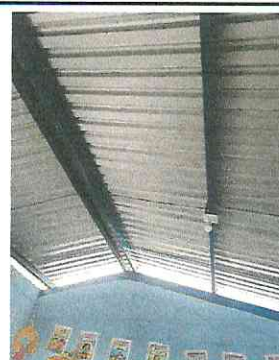
Foto 6: Mantenimiento a estructura (lijado, cambio de tubo , cepillado, sujeciones, aplicacion de pintura)
