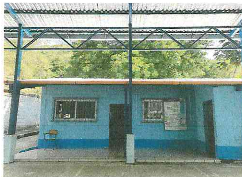
Foto 2: Instalacion de canal y bajada de pvc
